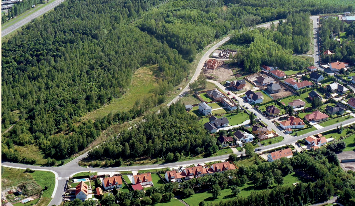
Nově vybudovaná přístupová komunikace na Čepirožské výsypce, která umožní další výstavbu rodinných domů.
